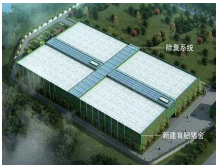
图 6.2-2 多层猪舍废气收集处理示意图
